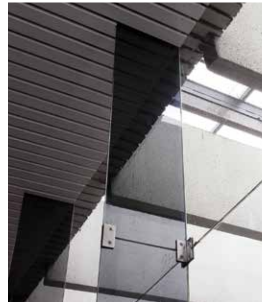
A pillérek által tartott tetőfödém és a füstüveg találkozási pontja, részlet Fotó: F. Szalatnyay Judit / Virtuális leletmentés © Kiscelli Múzeum 2019
